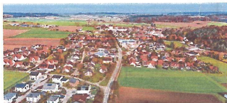
Die Bauarbeiten an der Ortsdurchfahrt in Baar beginnen am Montag. Foto: Stefanie Brand (Archivbild)
